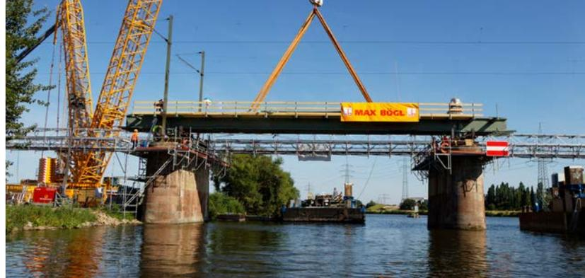
Im Zuge der Erneuerung der beiden dreifeldrigen Vorlandbrücken wurden die vorhandenen Kastenträger durch moderne, innovative Stahlkonstruktionen ersetzt.
