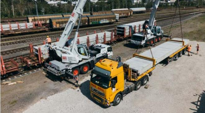
Für das Parkhaus-Projekt werden neben 441 Trogdeckenplatten auch rund 410 Träger und 400 Stützen im eigenen Fertigteilwerk unter höchsten Qualitätsstandards vorproduziert und mit dem Max Bögl-Fuhrpark zur Baustelle geliefert und montiert.
