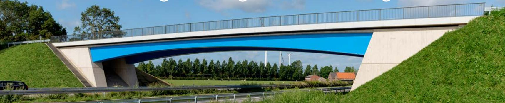
**Projektleiter Andre Deutenberg vom Landesbetrieb Straßenbau NRW war mit dem System und der schnellen Bauzeit der Modulbrücke Bögl bei Emmerich über die BAB 3 sehr zufrieden. „Die Brückenteile wurden komplett fertig angeliefert und die Elemente wie an einer Perlenkette aneinandergereiht. So konnten wir die Bauzeit von 120 auf 80 Arbeitstage reduzieren.“**
