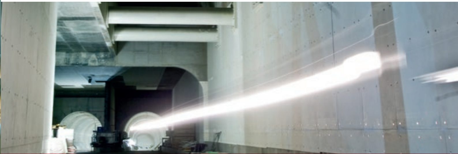
oben und links: Der Rohbau der Station Vijzelgracht entstand im Schutz einer Baugrundvereisung in Kombination mit einem Erdaushub unter Überdruck.
