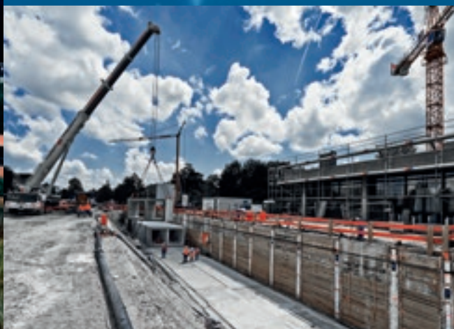
Präzise werden die Fertigteilmodule von einem Autokran in die zuvor mittels Bohrpfählen und Trägerbohlen gesicherte Baugrube eingehoben.
