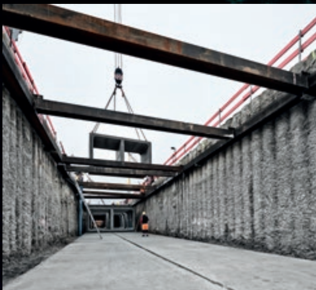
Präzise werden die Fertigteilmodule von einem Autokran in die zuvor mittels Bohrpfählen und Trägerbohlen gesicherte Baugrube eingehoben.
