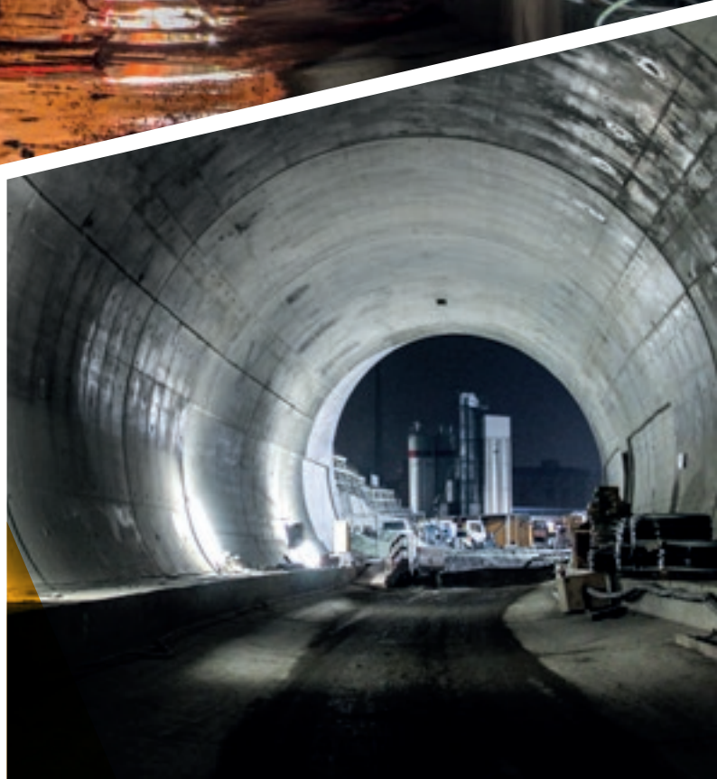
Shalungsarbeiten für den Einbau der Betoninnenschale aus WU-Beton
