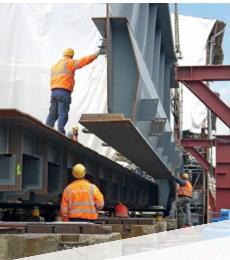
Zusammensetzen und Verschweißen der Stege mit der Fahrbahnplatte im Taktkeller
