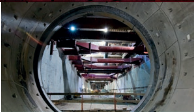
Im Endzustand wurden die Wände der Station De Pijp durch gewaltige Gabelstempel ausgesteift.
