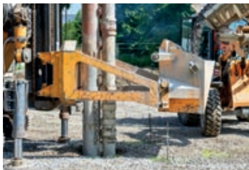
Einbringen des Zugabematerials in den Boden
