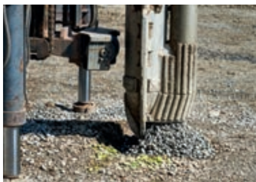
Abschnittsweise Verfüllung des verdrängten Bodenhohlraumes
