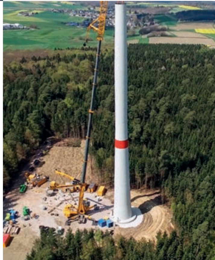
Präzise Montage des hybriden Windkrafttürms mit einem der weltweit leistungsstärksten Mobil-Teleskopkrane
