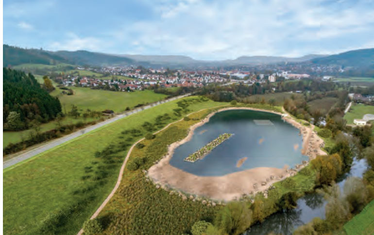
Unterbecken Naturstromspeicher: Simulation unterer/oberer Füllstand. Ein schwimmender Bio-Filter sorgt für dauerhaft klares Wasser.
