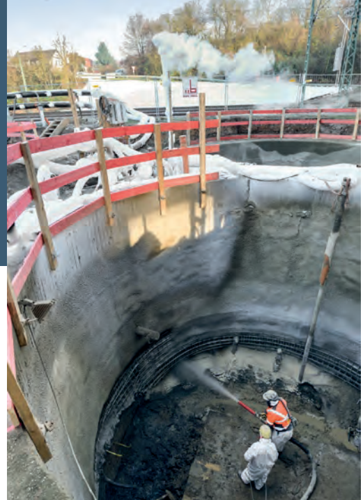
Mit Spritzbeton stabilisierter Schacht zum Einbau der Gründungselemente einer Autobahnbrücke bei Neckarsulm
