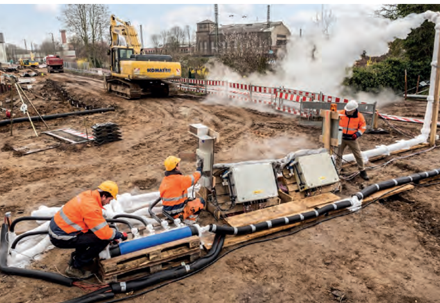
Baugrundvereisung inklusive Messtechnik, Stickstoffversorgung und Abgaskamin beim Projekt Ginsheim-Gustavsburg
